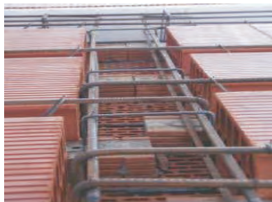
(تصویر 10.2.2: رینگ استحکام دهنده آهن کانکریتی بالای دیوار بردارنده داخلی)
