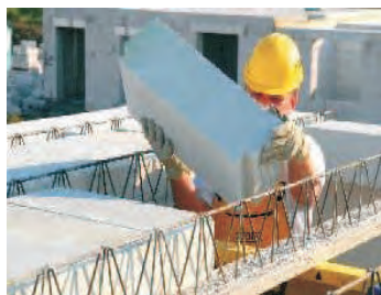
(تصویر 11.4.7: سیستم سلب بلوکی Ytong)
