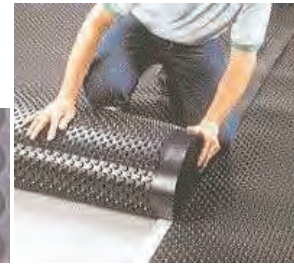
(تصویر 15.5.7: لایه دریناز از فویل HDPE)
