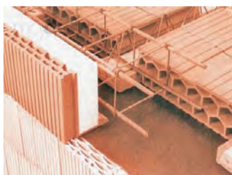
(تصویر 11.4.5: اندازه ها به میلی متر. سلب خشتی با لایه مسطح کانکریتی 6 سانتی متر)
