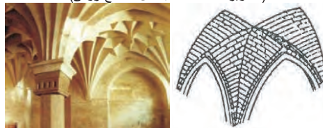
(تصویر 11.1.8: گنبد های متقاطع گوتیک)
