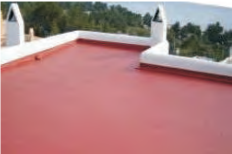
(تصویر 15.5.14: سطح نهایی عایق ضد آب مایع رنگه ICO PER با داشتن خاصیت الاستیکی)
