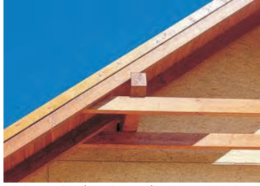
(تصویر 15.1.4: نمونه اتصال شده های مایل با کتیبه مرکزی و شده های افقی محکم گیرنده)
