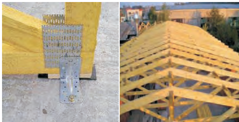
(تصویر 11.3.9: سلب بیم دار متقاطع با چوب های چهار تراش اتصال دهنده)
