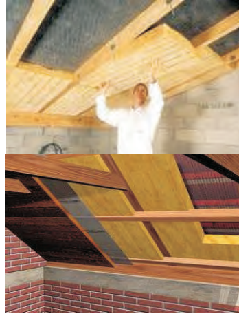
(تصویر 15.4.3: جابجایی عایق حرارت پشم شیشه در بین شده های مایل)
