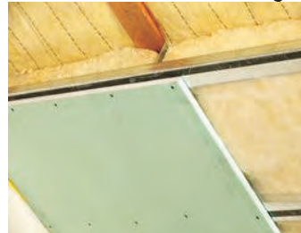
(تصویر 13.3.8: ساختار های پوششی گچ کاغذی که در داخل ساختمان استفاده می شوند)
