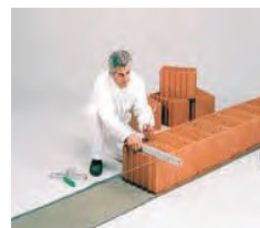
(تصویر 9.3.10: اعمار دیوار بدون فاصله فی مابین از خشت پخته بلوکی)
