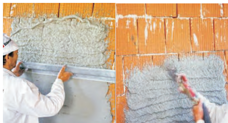
تصویر 13.2.2: پلاستر کاری دیوار توسط ماشین
