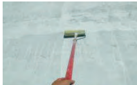
(تصویر 15.5.12: طرز کار تحت العایق که از ترکیب اصل عایق ضد آب ICO PER و آب معمولی بوجود آمده است)
