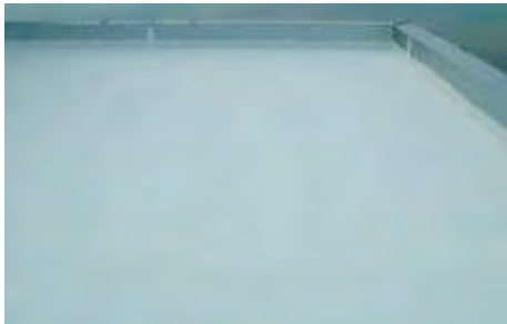
(تصویر 15.5.14: سطح نهایی عایق ضد آب مایع رنگه ICO PER با داشتن خاصیت الاستیکی)
