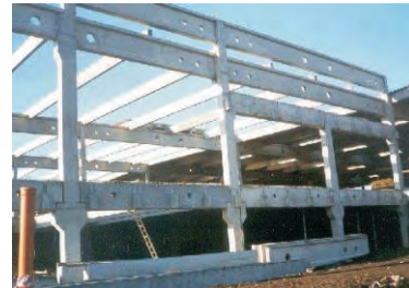
(تصویر 15.2.2: نمونه بام مایل بیم دار آهن کانکریتی)
