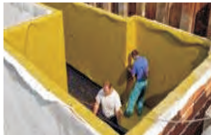
(تصویر 8.2.4: هیدروایزولشن های پلاستیکی که بشکل رول به ساحه ساختمان آورده می شوند و خود قابلیت چسپ را دارند و مستقیماً بروی کانکریت چسپانده می شوند.)
