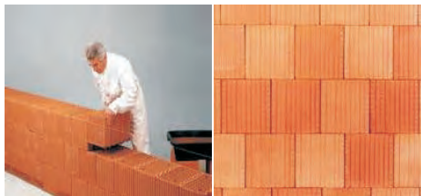
(تصویر 9.3.12: اعمار دیوار از خشت پخته بلوکه ای ابعاد بزرگ با اتصال جری و جوک مانند و بدون فاصله فی مابین)
