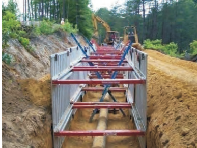
(تصویر 5.3.4: کندنکاری ته‌داب ها و تخته بندی بخاطر جلوگیری از لغزش)
