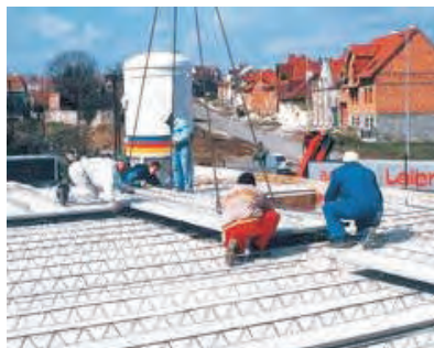
(تصویر 11.6.10: نصب سلب Filigrán آهن کانکریت)
