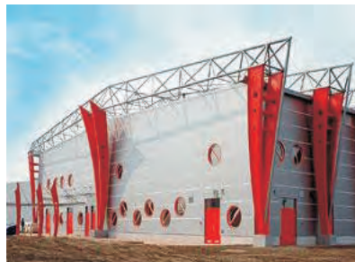
(تصویر 15.3.1: نمونه بام مایل چوکاتی فلزی)
