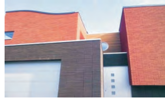
(تصویر 9.1: از روکار ساختمان بدون پلاستر اعمار شده از خشت پخته)
