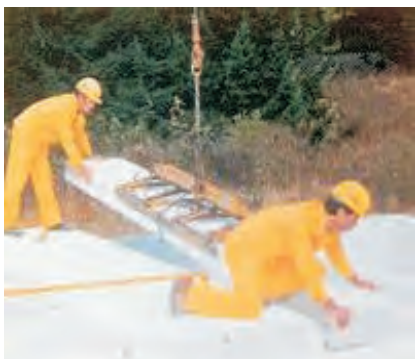
(تصویر 11.6.13: نصب سلب های مانولیت با قالب بندی بجا مانده از پانل های سلب پارو کانکریت) سلب های مانولیت یا یکرخت با قالب بندی بجا مانده از پانل سمنت و ذرات پائیلی
