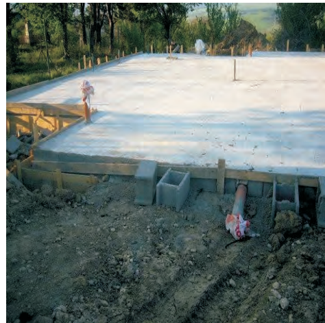
(تصویر 6.2,9: نمونه تهاداب های فیته ای مرکب از کانکریت ساده)
