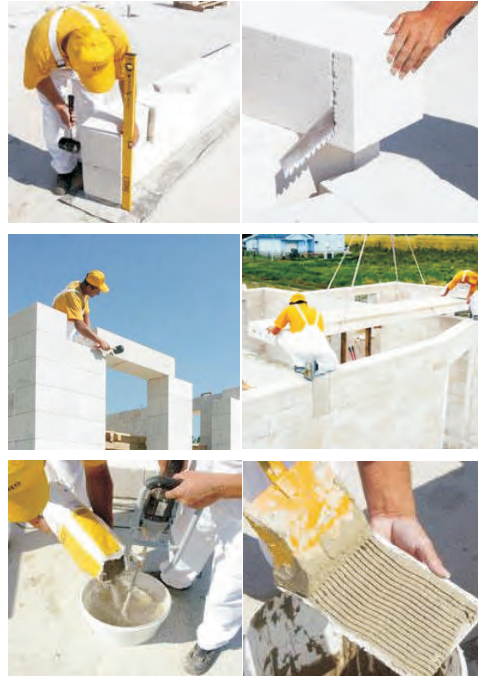
(تصویر 9.5.3: اعمار دیوار از بلوک های پاروکانکریت سفید رنگ)
