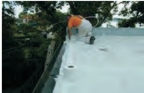
(تصویر 15.5.13: تقویت کنج ها و درز ها توسط جال شیشه ای)
