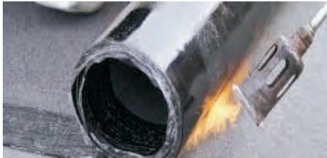
(تصویر 8.4.1: نصب هیدروایزولشن توسط تفنگچه مخصوص)
