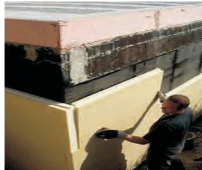
(تصویر 8.4.5: لایه حفاظتی هیدروایزولشن عمودی توسط پالسترین (XPS))
