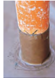
(تصویر 8.4.10: مشخصات عبور لوله فاضلاب در سطحی که هیدروایزولشن در آن نصب گردیده است.)
