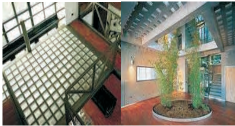
(تصویر 11.8.1: ساختار سلب کانکریت شیشه ای)
