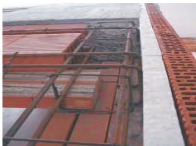
(تصویر 10.2.1: رینگ استحکام دهنده آهن کانکریتی بالای دیوار بردارنده احاطوی که از طرف بیرون با پالسترین و خشت رینگی محافظت می شود)
