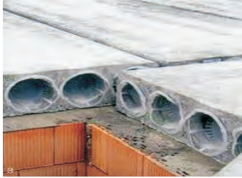
(تصویر 11.7.4: سلب آهن کانکریتی پیش ساخته از قطعات فابریکه ای)
