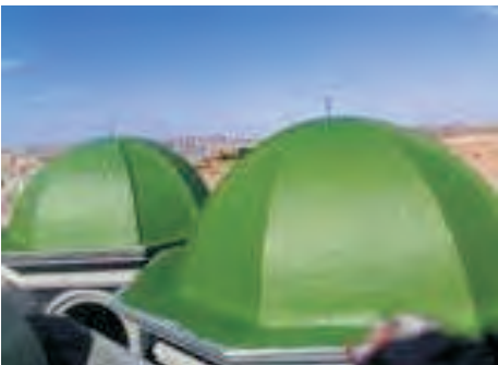
(تصویر 15.5.15: عایق ضد آب مایع رنگه با داشتن خاصیت الاستیکی (ICO PER))
