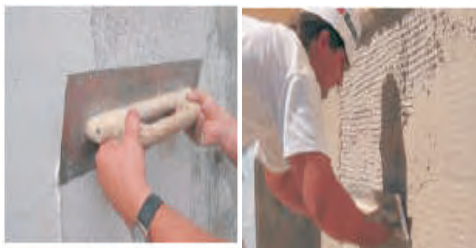
(تصویر 13.2.4: طرز کشانیدن پلاستر بروی دیوار)
