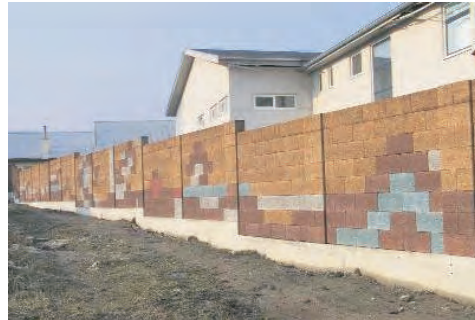
(تصویر 9.5.9: عایق در مقابل صدا توسط اعمار دیوار از بلوک های کانکریتی سبک شده اورگانیک)
