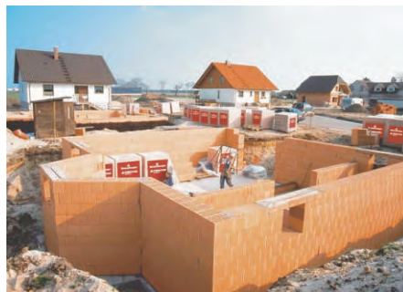
(تصویر 7.2.2: نمونه ساختارهای باربر خشتی طبقه زیر زمین ساختمان)
