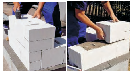
تصویر 9.4.4: اعمار دیوار از بلوک های پرس شده ریگ و چونه)
