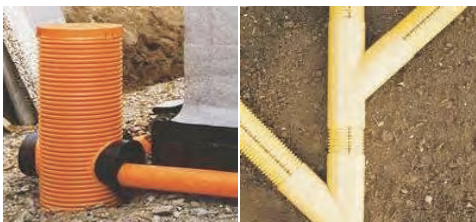
(تصویر 8.1.1: نصب و جابجایی پیپ دریناژ در اطراف ساختمان)
