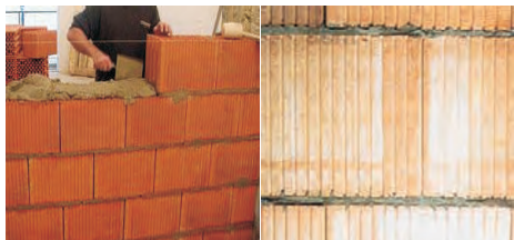
(تصویر 9.3.11: اعمار دیوار از خشت پخته بلوکی میان خالی با استفاده از مصالحه)
