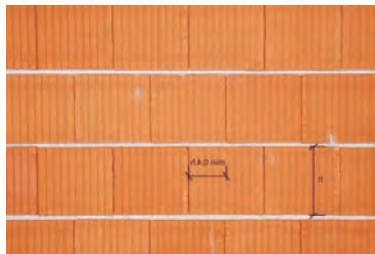
(تصویر 9.3.22: اعمار دیوار خشتی با استفاده از ملات ساده)
