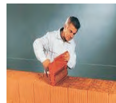
(تصویر 9.3.10: اعمار دیوار بدون فاصله فی مابین از خشت پخته بلوکی)
