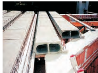
(تصویر 11.7.3: سلب پیش ساخته شده از پائیل آهن کانکریت فابریکه ای)
