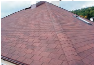
(تصویر 15.4.19: نمونه پوشش اسفالتی Shingles)
