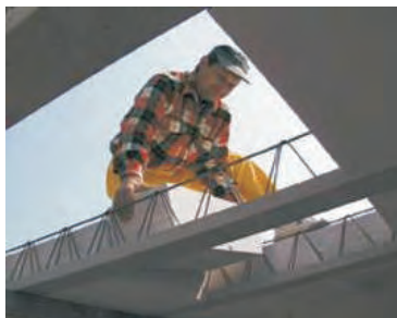
(تصویر 11.4.8: ایجاد و حفظ دهانه در داخل سلب)
