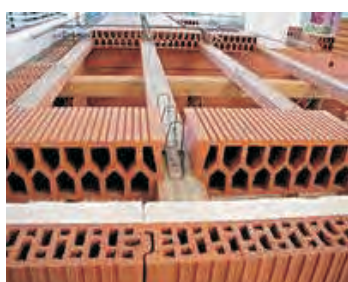
(تصویر 11.4.6: سیستم سلب خشتی Porotherm)
