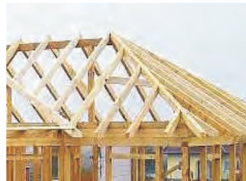
(تصویر 15.1.1: نمونه ساختار مایل بام چوبی)
