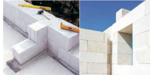
(تصویر 9.5.1: اعمار دیوار از بلوک پاروکانکریت سفید رنگ)
