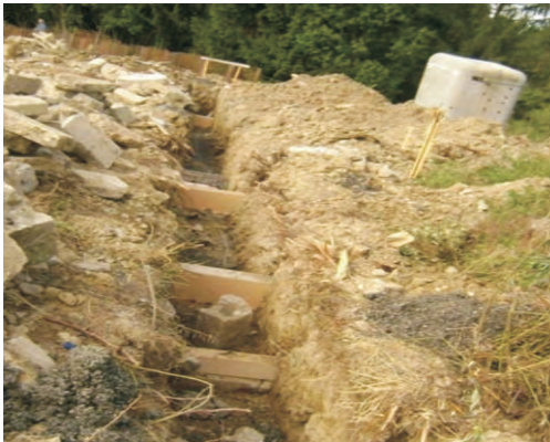
(تصویر 6.2.20: ایجاد تونل های کوچک در سطح تختانی تهابد قبل از ریخت بتن)
