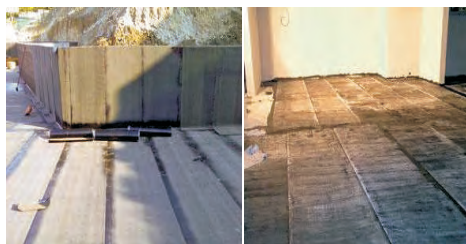
(تصویر 8.2.3: در هنگام نصب هایدروایزولشن بیتومینی باید دقت شود که حداقل 10 سانتی متر یکی بالای دیگر قرار بگیرند)
