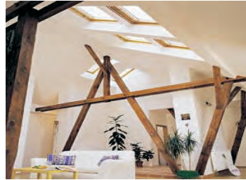
(تصویر 15.1.1: نمونه ساختار مایل بام چوبی که در داخل اطاق قابل دید می باشد)
