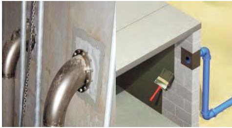
(تصویر 8.4.11: لایه حفاظتی هیدروایزولشن عمودی از نورناپ)
