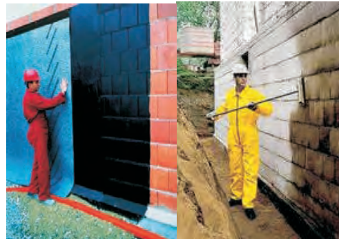
(تصویر 8.4.4: لایه حفاظتی هیدروایزولشن عمودی)
