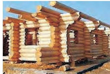
(تصویر 9.7.6: نمونه ساختمان اعمار شده از دستک های چوبی)
