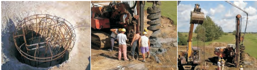
(تصویر 6.3.8: پایل های مایکروپایل. الف- مراتب ایجاد و تولید مایکروپایل؛ ب- مایکروپایل کجدار و شیبدار زیر تهاداب موجوده)
