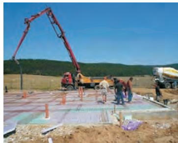
(تصویر 6.2.19: نمونه های عملی از اعمار تهابد های مسطح)
