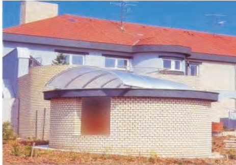
تصویر 9.4.5: اعمار دیوار از بلوک های پرس شده ریگ و چونه M 25 که ضرورت به پلاستر ندارد)
