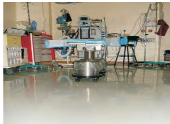
(تصویر 14.15: فرش آنتی ستاتیک اپوکسی در عملیاتخانه شفاخانه)
