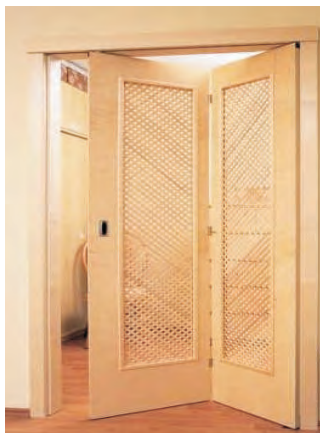
(تصویر 17.3: نمونه از طرز باز نمودن دروازه فرشی یا قاتی)
