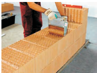
(تصویر 9.3.13: کشانیدن ملات چسبی توسط غلطک بروی بلوکه خشتی)
