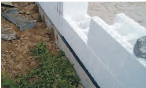
(تصویر 9.5.12: ترتیب اعمار ساختمان از بلوک های پالسترین تاترامات 2000)
