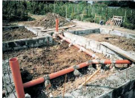
(تصویر 5.4.1: نصب لوله های آب، کانال و برق قبل از پرکاری)
