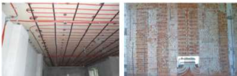
تصویر 4.26 از راست به چپ: سیستم تسخین دیواری، سیستم تسخین سقفی
