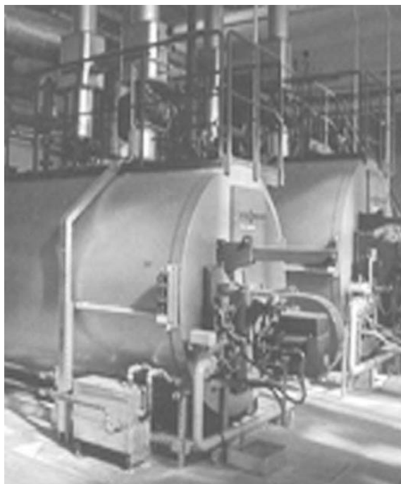
د جوش اوبو او بخار د توليدولو بايلر چې د فيسمن (Viessmann) د شرکت له خوا بازار ته وړاندي کېږي
