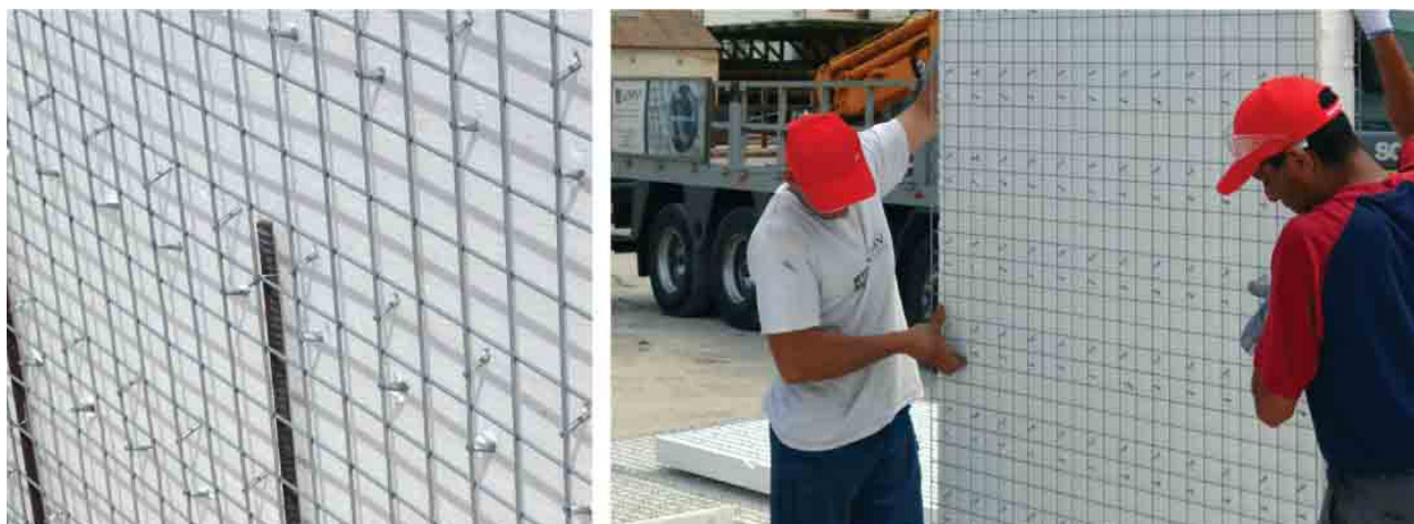
تصویر 2. پنل 3D و نقاط به وجود آوردن پل حرارتی در آن
